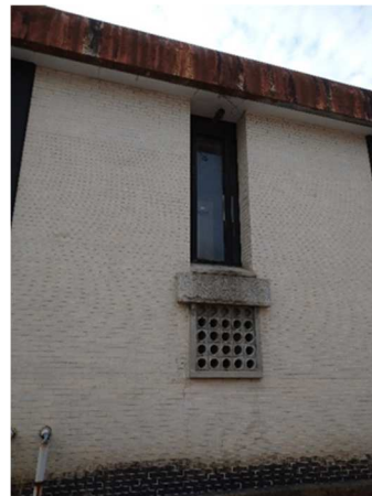
(↑四同舎 正面窓)
