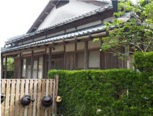
(↑ 樋が竹の様子)
