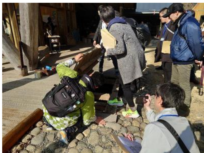
(↑ デッキの施工方法に興味津々の参加者)
